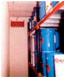
Nave de Productos Inflamables
